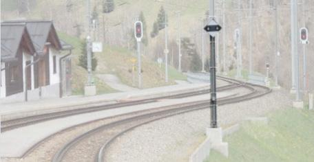
Das Fakultativhaltssignal (eine auf der Spitze stehende weiß-schwarz-weiße quadratische Tafel mit einem oder zwei weißen Blinklichtern) wird bei Haltestellen mit Bedarfshalt angewendet. Es befindet sich im Bereich des Einsteigeortes, meist (beidseitig) in der Mitte des Bahnsteigs - alternativ an dessen Anfang. Wenn kein Halt nötig ist, darf ein Zug mit maximal 60 km/h durch den Bahnhof bzw. Haltepunkt fahren. Das Signal wird vom Fahrgast betätigt. Es schaltet sich nach einigen
