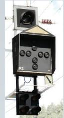
Das Bild zeigt eine interessante Kombination von Rangierhaltsignal, Abfahrtsignal, Zuordnungspfeil und dem Kontrolllicht für den Bahnübergang. © Martin Langenbach
